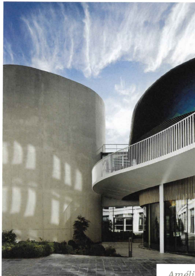
In/Out, la tour centrale du pavillon de services
